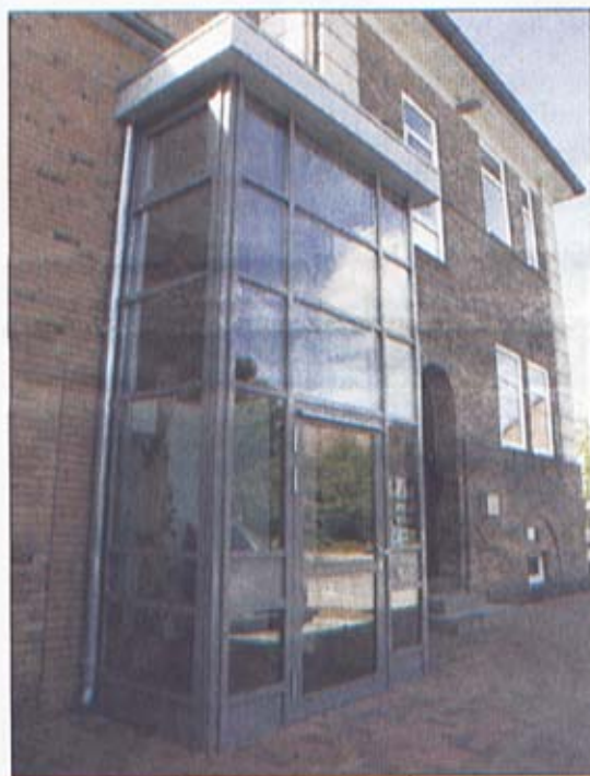
Das Obergeschoss des ehemaligen Amtsgebäudes ist zu Praxisräumen umgebaut worden. Sie sind auch über einen neu gebauten Fahrstuhl auf der Rückseite barrierefrei zu erreichen. Fotos: Petersen
